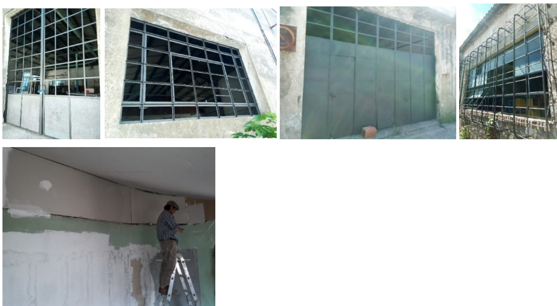
Figura 6. Obras ejecutadas por la FAU-UNLP a partir del trabajo realizado por los alumnos.
